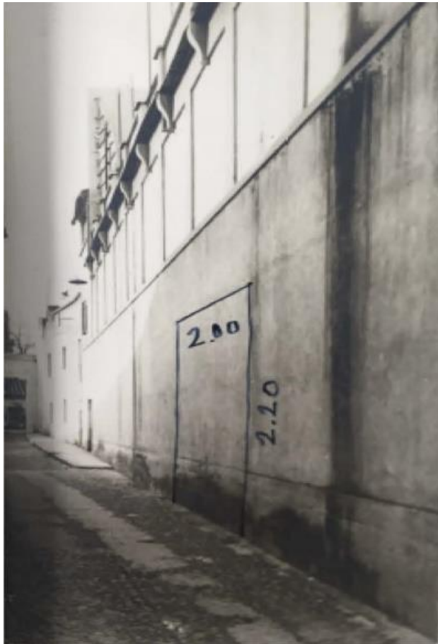
Fig. 7. Fotografía de reforma del cinematógrafo en Plaza de la Magdalena 2a. Apertura de puerta lateral a Calle Santa Inés. 1959. Fuente: AHMC, 1959: 000587-011.
